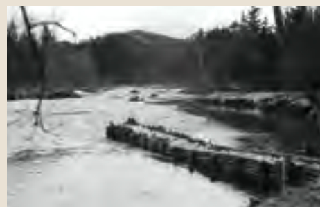
Foto / Photo: Peter Naglič, 1937 (Dokumentacija SEM / SEM Documentation)
